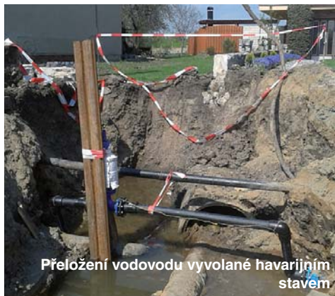
Křížení vodovodu se zatrubněným potokem
