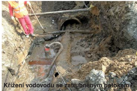
Přeložení vodovodu vyvolané havarijním stavem
